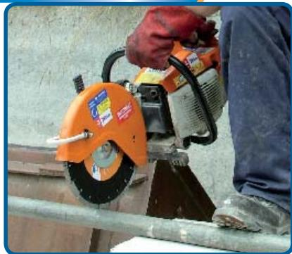
**Belle Silver Plus** assortiman visoko segmentiranih diamantnih reznih plošč, z laserskim dvojnim varjenjem, višine 10mm, je dizajniran tako da nudi veliko hitrost rezanja, dolgo življenjsko dobo in dobro vrednost za ceno.
